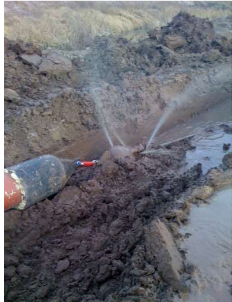
BROCA TRABAJANDO Y LANZANDO AGUA CON BENTONITA PARA LUBRICACION
