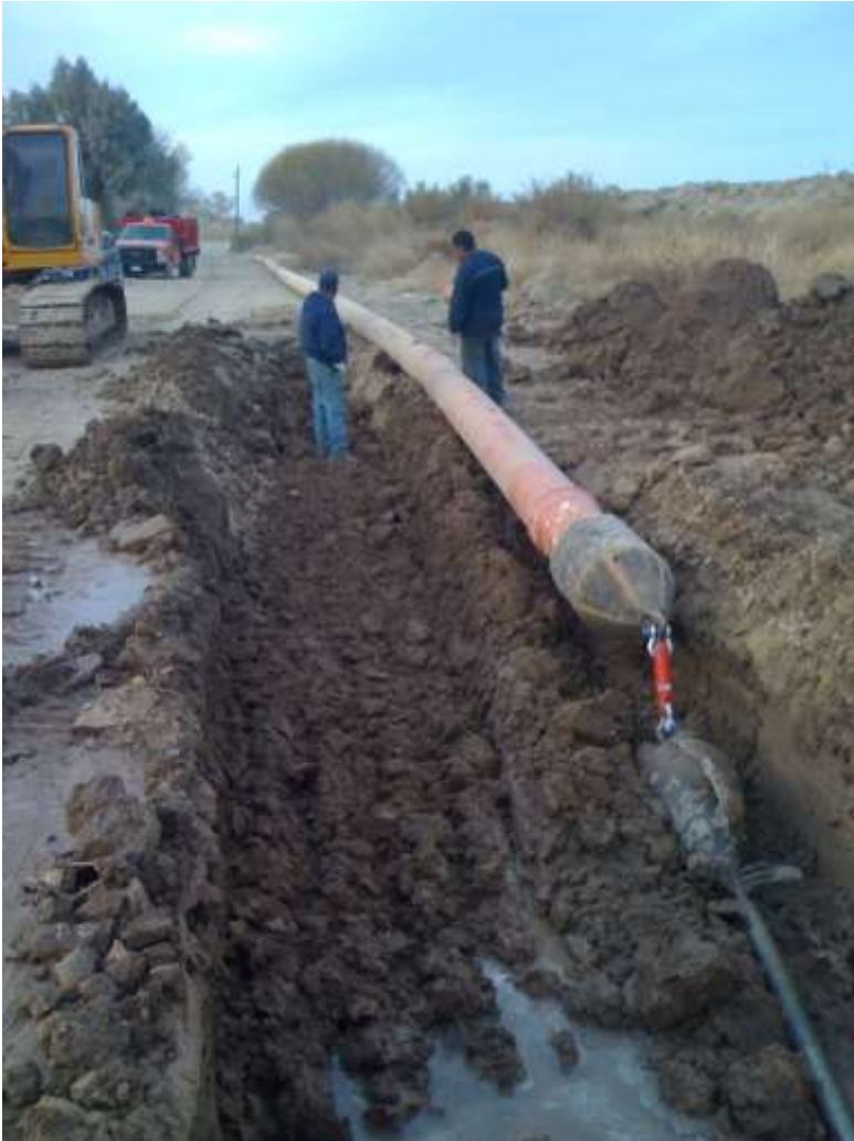
TUBERIA LISTA PARA INICIAR PROCESO DE JALADO HACIA DENTRO DEL TUNEL
