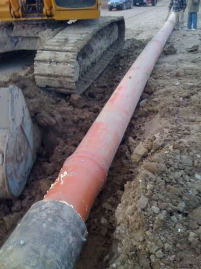
EXCAVADORA PREPARANDO RAMPA DE ENTRADA AL TUNEL DE PERFORACION
